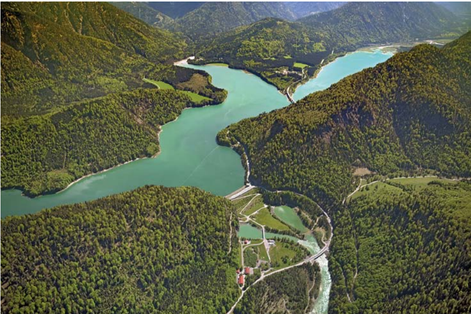
Abb. 1: Die Talsperre Sylvenstein am Oberlauf der Isar ist seit 1959 in Betrieb, schützt München vor Hochwasser und liefert mit zwei Kraftwerken zuverlässig elektrische Energie. Quelle: Hajo Dietz
